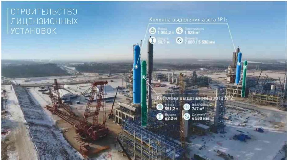
Рисунок 24. Строительство Лицензионных установок. Колонны выделения азота №1 и №2.
