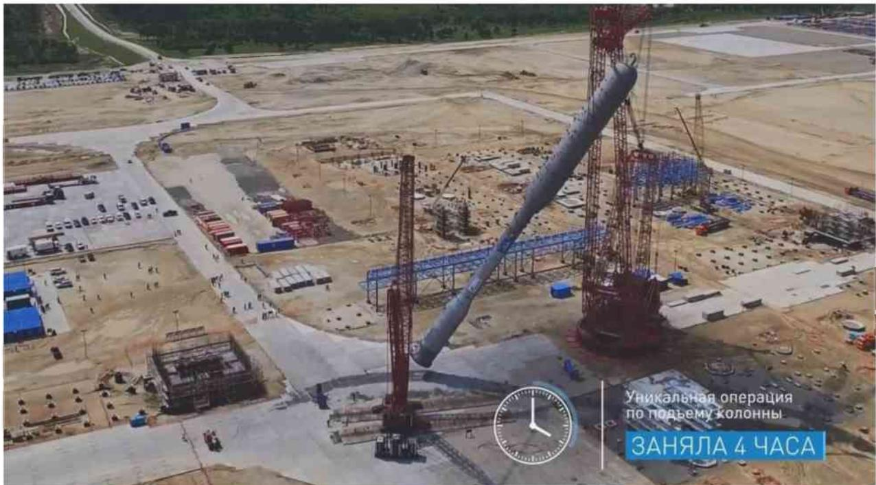
Рисунок 21. Монтаж первого крупногабаритного оборудования.
