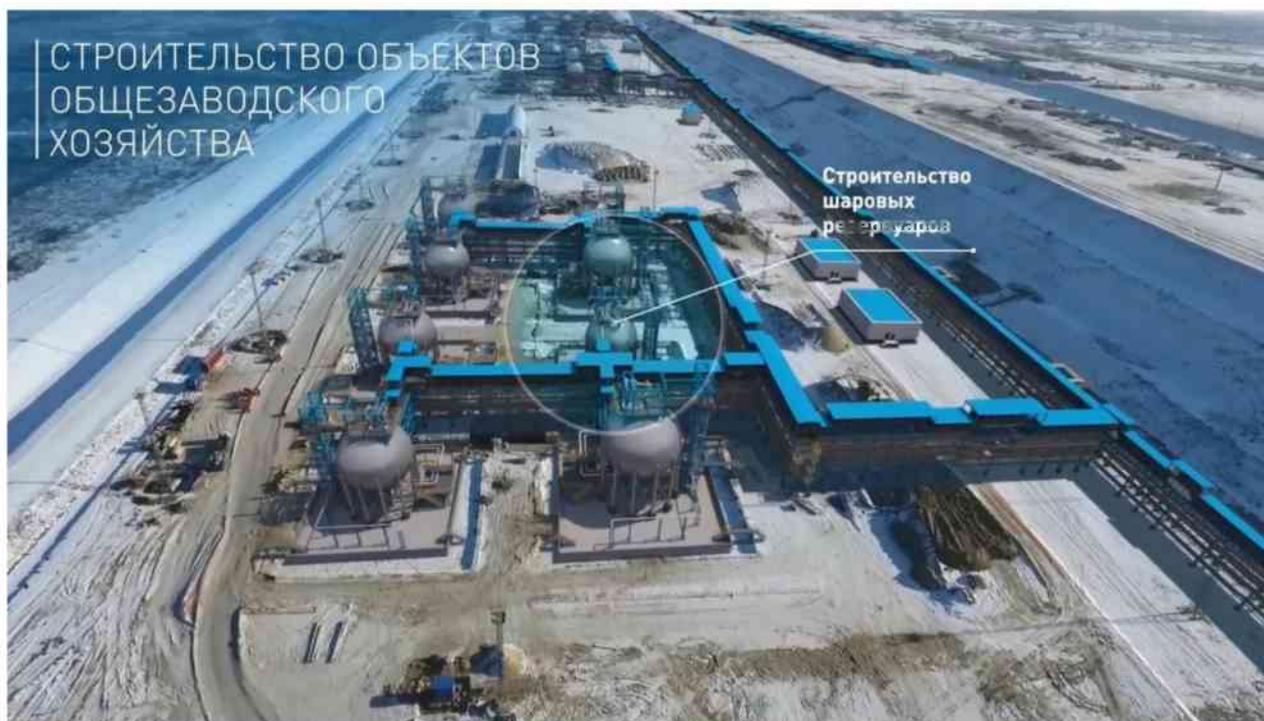
*Рисунок 15. Строительство объектов ОЗХ. Резервуарный парк, строительство шаровых резервуаров.*
