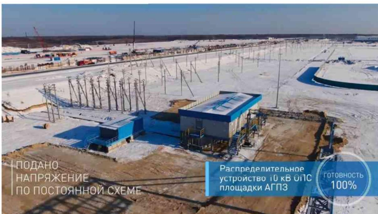
Рисунок 6. Строительство внутриплощадочных сетей электроснабжения 10 кВ площадки АГПЗ.
