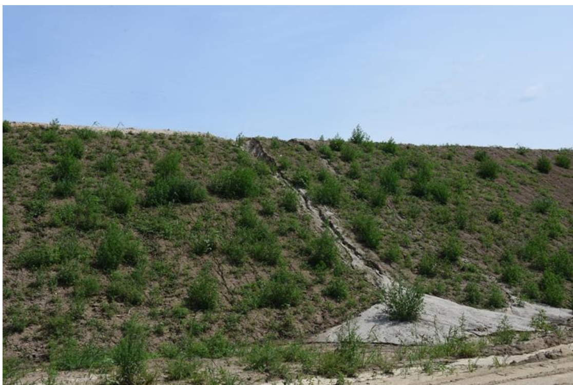
Рис. 34. Дождевая эрозия на склонах
