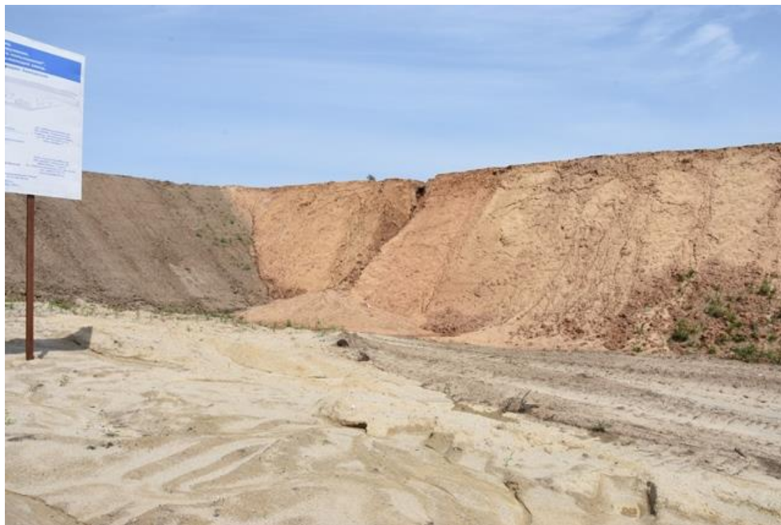
Рис. 31. Дождевая эрозия на склонах
