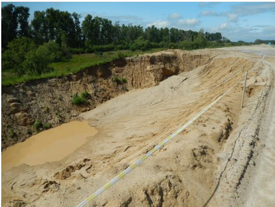
Рис. 33. Дождевая эрозия на склонах
