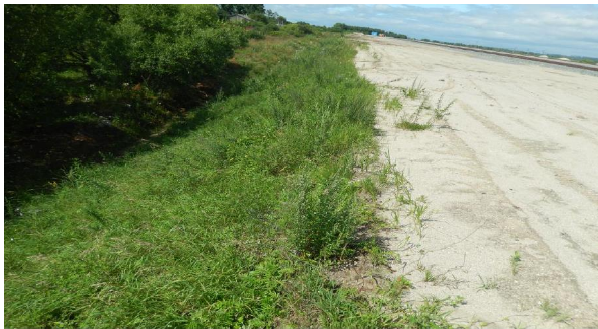
Рис.27 Залесена кустарниковой и древесной растительностью
